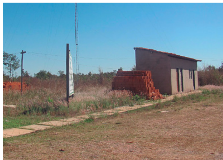
Nesta construção ficará a área administrativa do local
